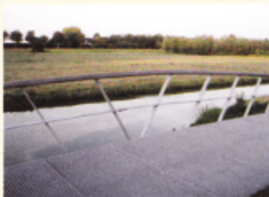
De reling van de brug
