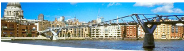
figuur 7: de Millennium Bridge wiebelde te hard bij de opening vanwege het grote aantal voetgangers dat over de brug liep
